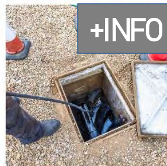
Tuberías y desatascos
