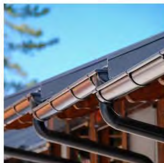
Colocación de canalones
